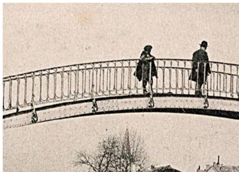
Passerelle de Nègreneys
